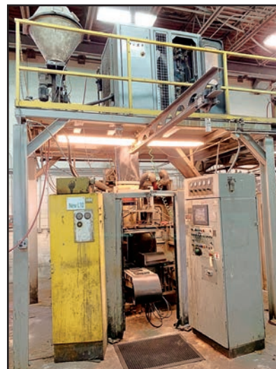
LAEMPE L-10 COLD BOX CORE CELL
